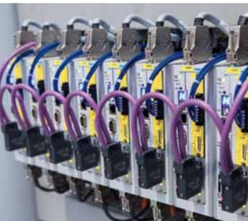
**CMMP-AS-Servocontroller** steuern die elektrischen Antriebe auf der Anlage.
